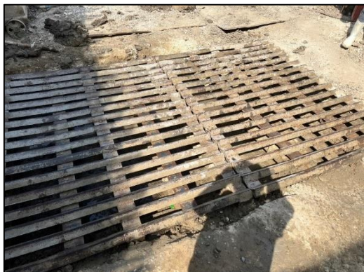
ภาพที่ 13 ปูแผ่นเหล็ก
